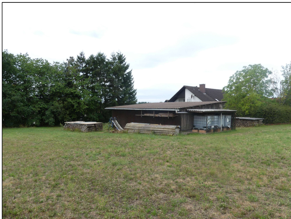
Abb. 4 Östlicher Teil des Geltungsbereiches, Blick nach Südwesten (25.08.2020)
